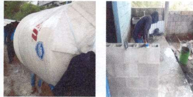
Foto 6: Sustitución de deposito de agua y muro de contención
