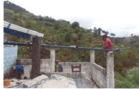
Foto 2: Mantenimiento a estructura de soporte metal.
